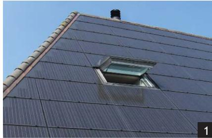
1: Die optimal integrierte PV-Anlage in Uettilgen/BE "erntet" jährlich 182 kWh pro m<sup>2</sup> Dachfläche für das sanierte Bauernhaus von 1819.
